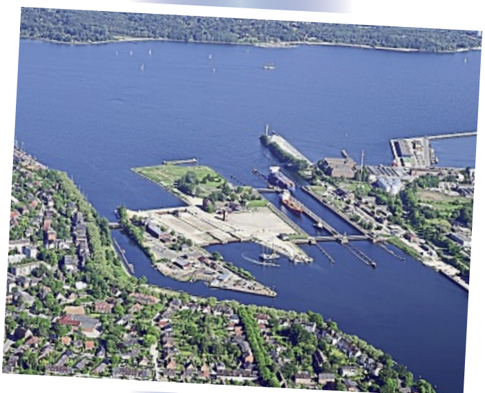
Die Kieler Schleuse in Holtenau ist ein wichtiger Bestandteil der maritimen Infrastruktur in Schleswig-Holstein. Alle Schiffe, die den Nord-Ostsee-Kanal nutzen wollen, müssen hier durch.
