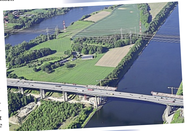
Aus der Vogelperspektive ist zu sehen, wie die neue Rader Hochbrücke neben dem alten Bauwerk entsteht und nicht mehr viel bis zum Lückenschluss über dem Nord-Ostsee-Kanal fehlt.
